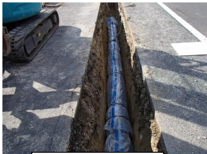
開削工事（中津川市内）
