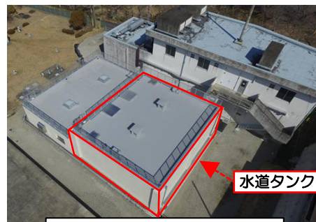
ポンプ所全景（中津川市内）
