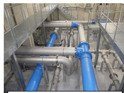
所内配管の整備状況（中津川市内）
