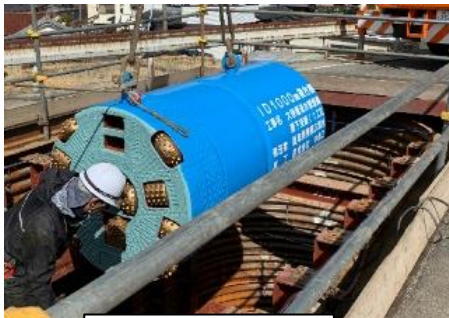
推進工事（恵那市内）
