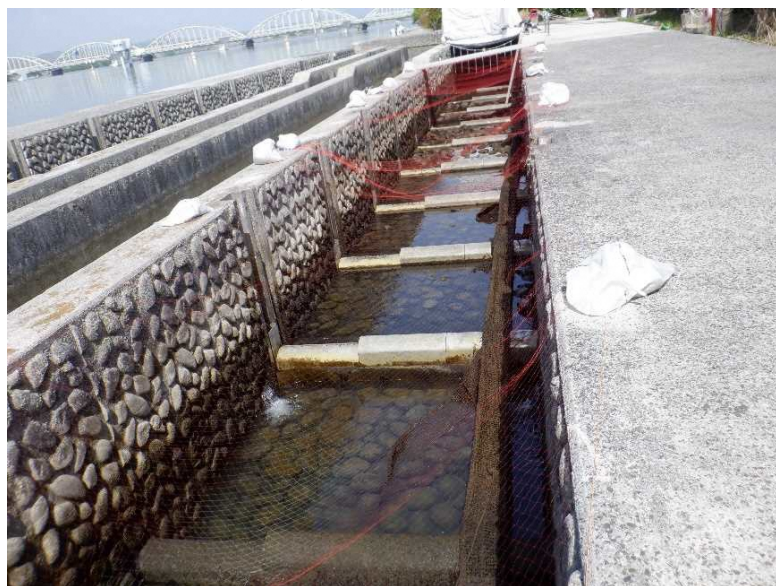
呼び水式魚道への防鳥ネットの設置状況 （令和5年4月）
