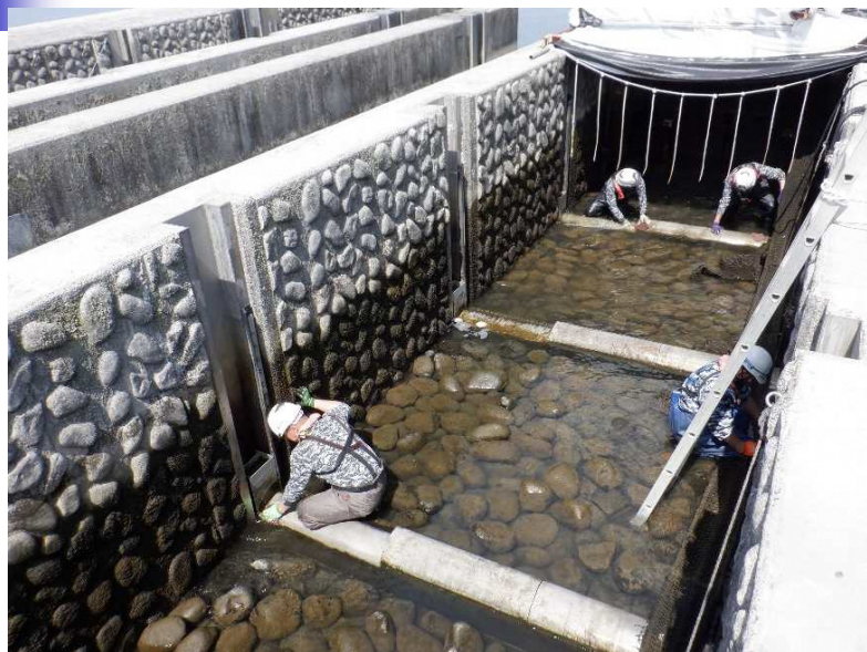
左岸呼び水式魚道の清掃状況 （令和5年4月）
