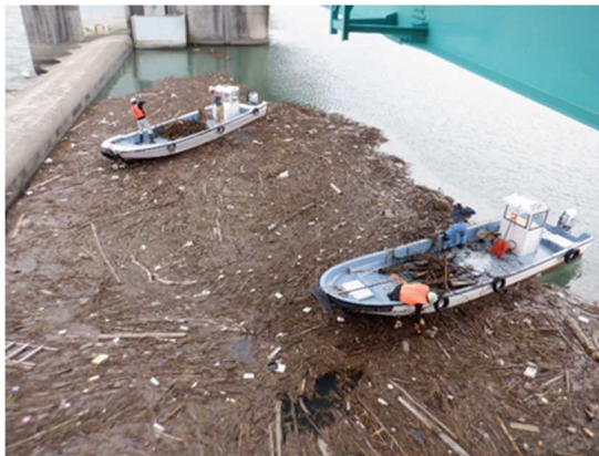
堰上流に滞留した漂着物の回収作業
