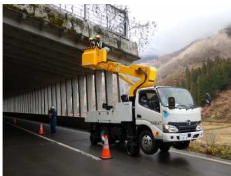
高所作業車による点検
