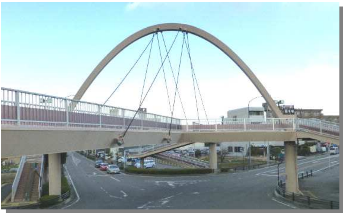
主要地方道 岐阜環状線 芋島歩道橋（岐阜市） 1999年架設（主塔ア一チ型鋼斜張橋）
