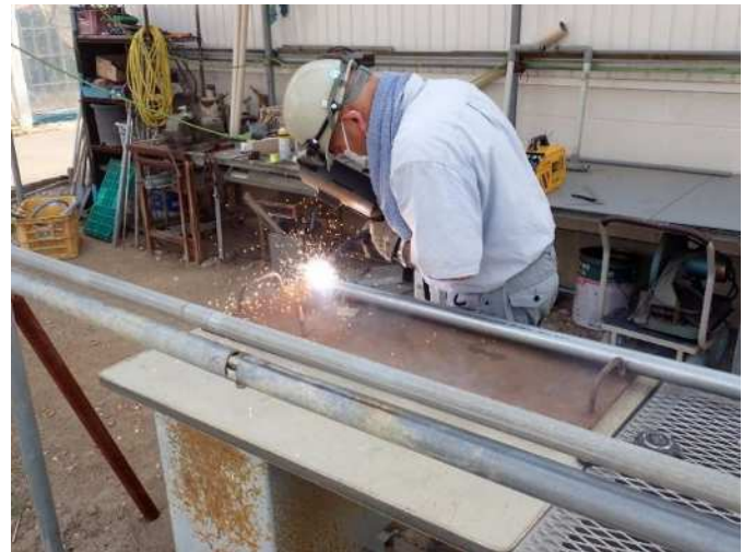
防風ネットの支柱の溶接作業
