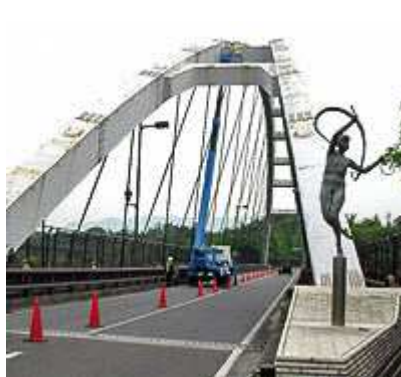
近接目視点検（下路ローゼ橋）
