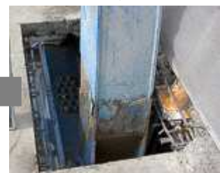
床版はつり完了
