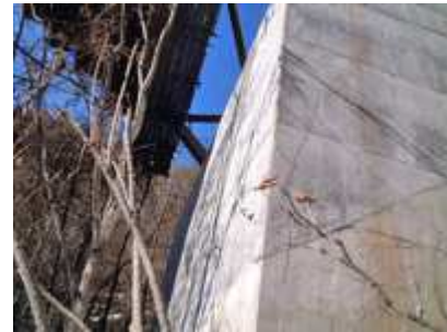
ひび割れ補修後
