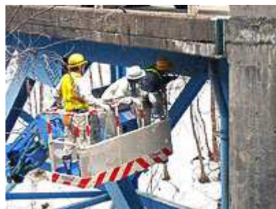
一般交通を規制しての詳細な点検
