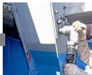
補強板の取り付け
