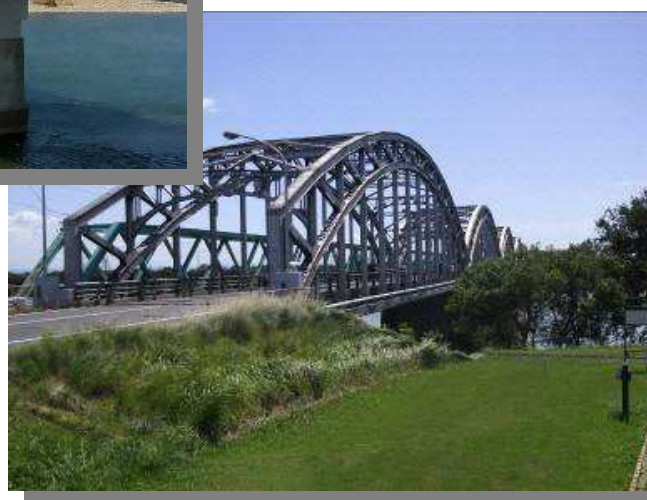
左：一般国道157号 忠節橋（岐阜市） 1948年架設（鋼ゲルバー式ブレースドタイドアーチ橋） 右：主要地方道 岐阜稲沢線 木曾川橋（羽島郡笠松町） 1937年架設（鋼ブレースドリブタイドアーチ橋）
