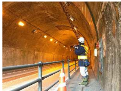
MEによるトンネル緊急点検
