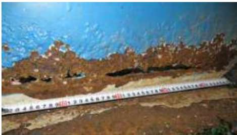
主桁腐食
