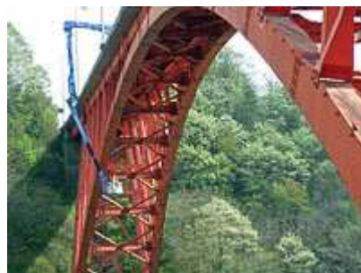
近接目視点検（上路アーチ橋）
