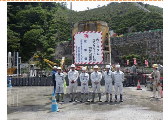
コンクリート打設30万m 3 達成
