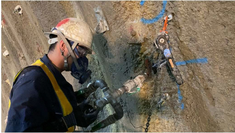
注入準備作業
