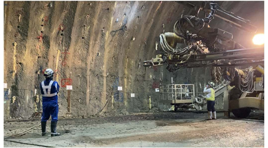
注入作業中の漏出確認
