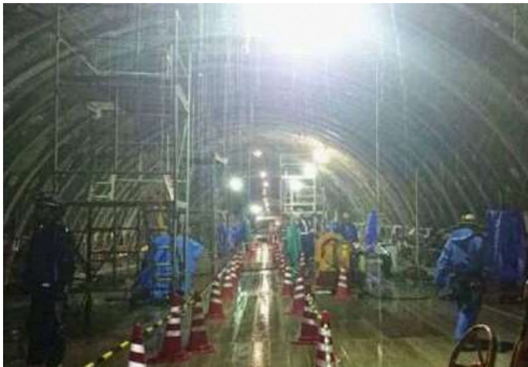
施工前 (作業時には雨合羽が必要であった)
