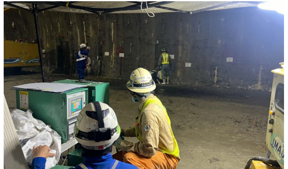
注入作業中における確認
