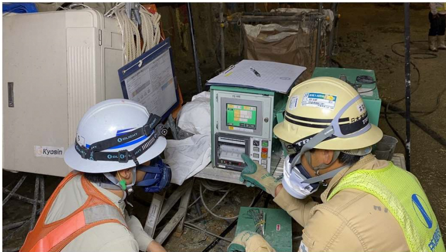
注入量と圧力値の確認
