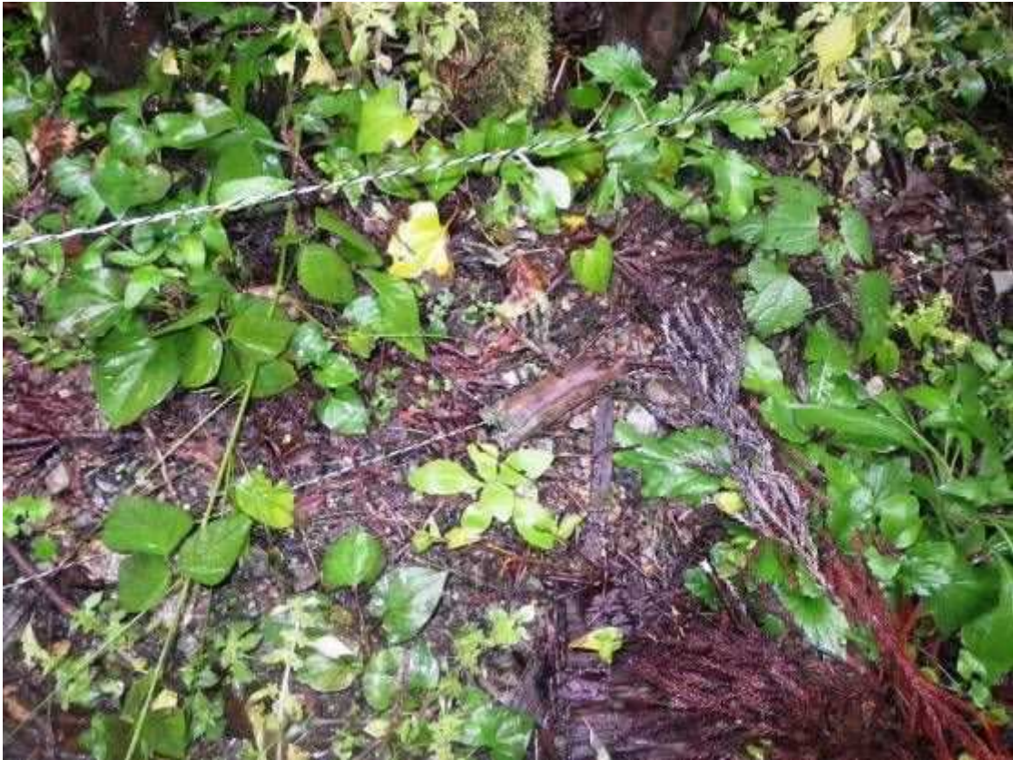
「地面に接触している電気柵」
