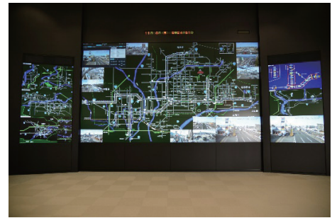
交通管制センター
