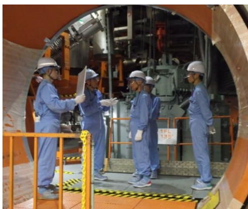
廃止措置計画の変更認可申請に係る 内容を確認している様子 (2号機 原子炉格納容器入口)
