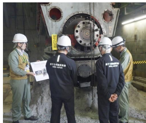
廃止措置に関する現状等を確認している様子 (2号機 非常用ディーゼル発電機)
