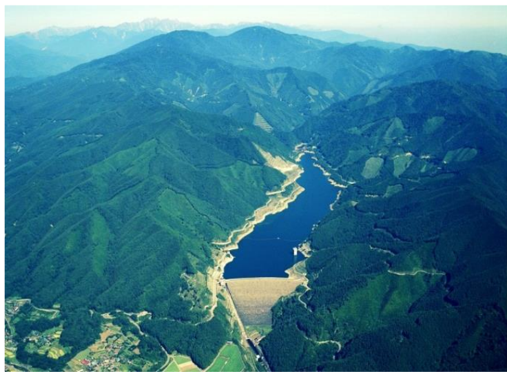
【味噌川ダム】 木曾川(長野県木祖村)
