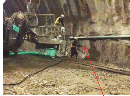
挿入した鋼管から薬液を注入
