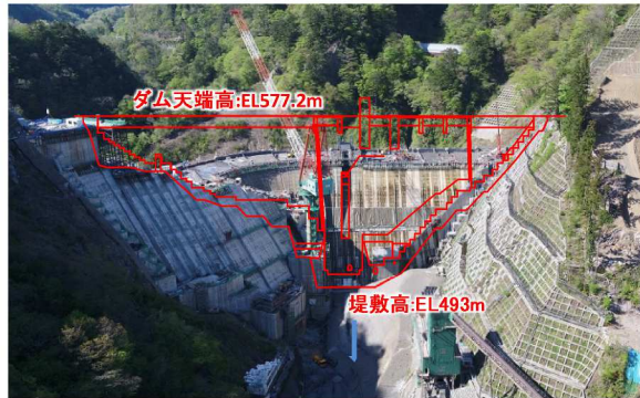
① ダムサイト状況(下流上空より望む)
