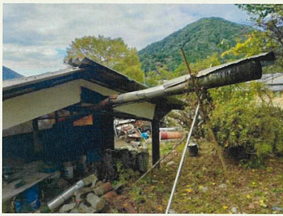
川上で稼動中の炭焼き小屋の煙突
