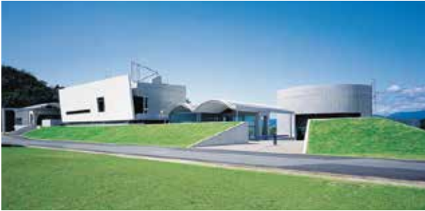
公園に似ているかのような本社は「関工園」の名で親しまれ、敷地内にはコンサートホール、美術館などが入っている。
