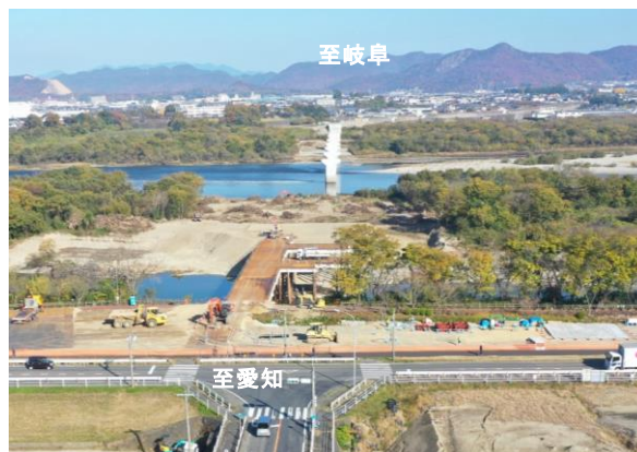
(一) 扶桑各務原線 新愛岐道路 工事状況
