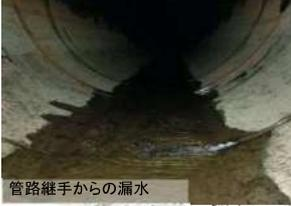
管路継手からの漏水
