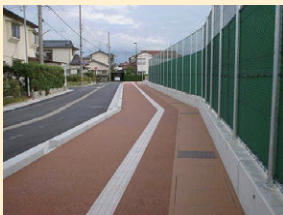
瓦骨材利用透水性樹脂舗装材 K-グランドR 陶磁器くず(廃瓦) 株式会社佐美組 TEL 0584-89-6611
