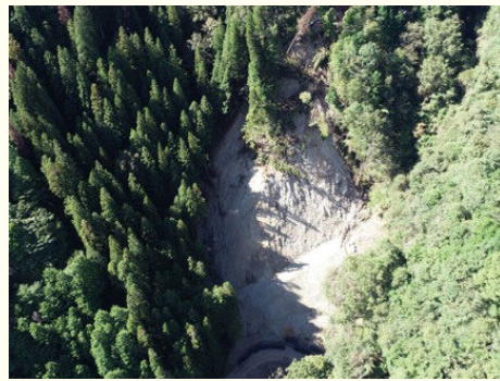
▲施工前の現場
