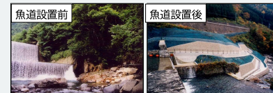
▲既設砂防えん堤の魚道整備(郡上市明宝 坂本)
