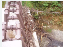
透過型砂防えん堤の流木捕捉状況 (郡上市八幡町 神奈良川)
