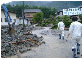
平成20年9月 西濃豪雨 揖斐川町 大谷
