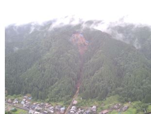
令和2年7月 8月大雨災害 郡上市大和町島
