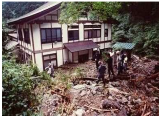
平成元年9月 9.7 豪雨災害 揖斐川町谷波・横蔵寺
