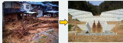
災害復旧状況(平成16年台風23号豪雨災害:高山市江名子町荏名谷)
