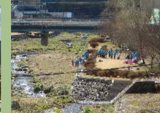
▲小川谷の溪流保全工
