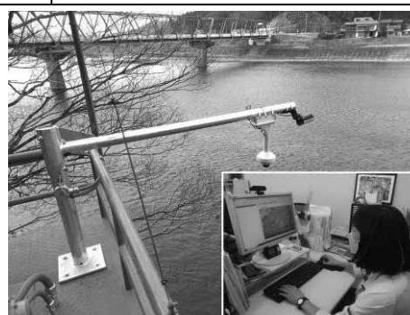
ゲートの遠隔監視
