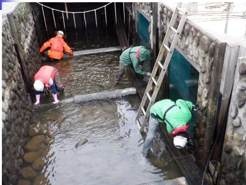
左岸呼び水式魚道の清掃状況 （令和4年5月）
