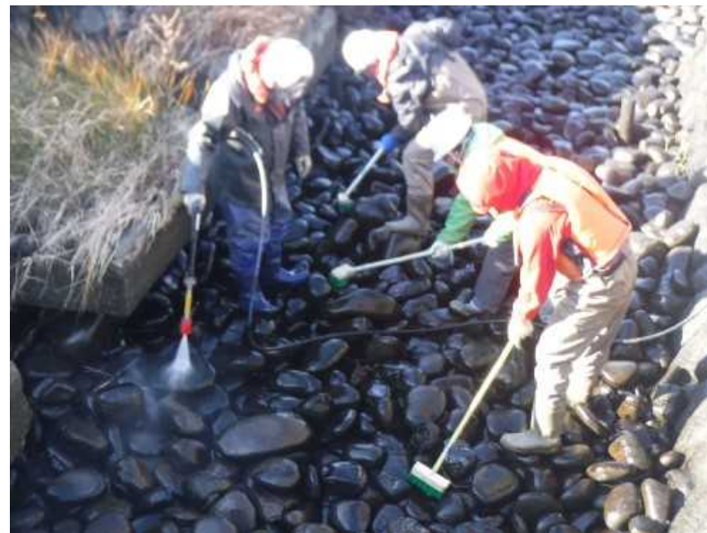
右岸せせらぎ魚道の清掃状況 （令和4年1月）
