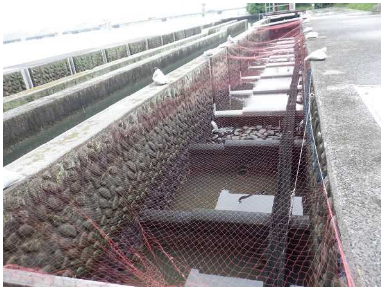
呼び水式魚道への防鳥ネットの設置状況 （令和4年5月）
