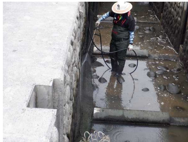
右岸呼び水式魚道の清掃状況 （令和4年7月）
