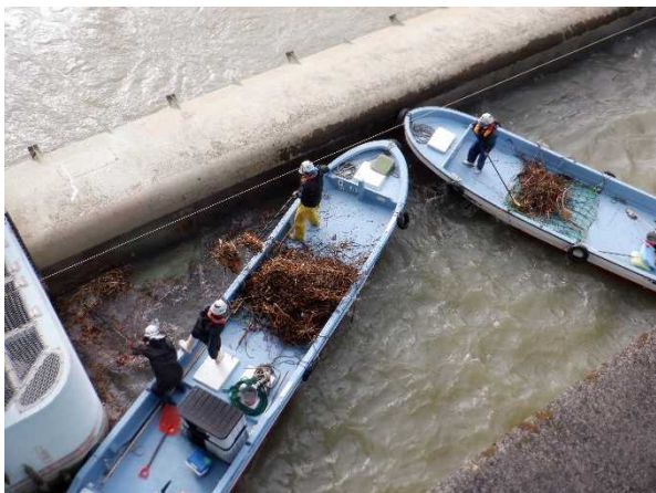
堰上流に滞留した漂着物の回収作業 (令和4年12月)
