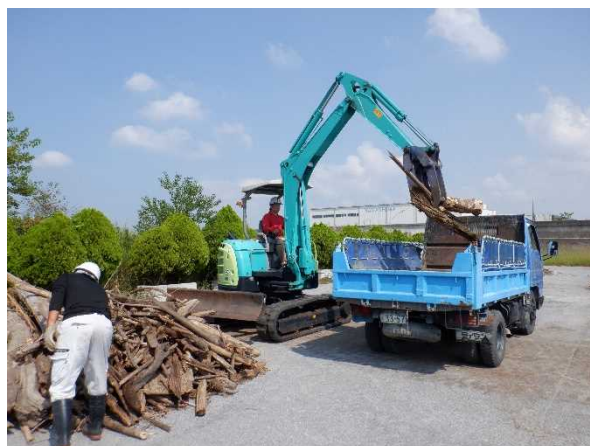
漂着物の搬出作業 (令和4年9月)
