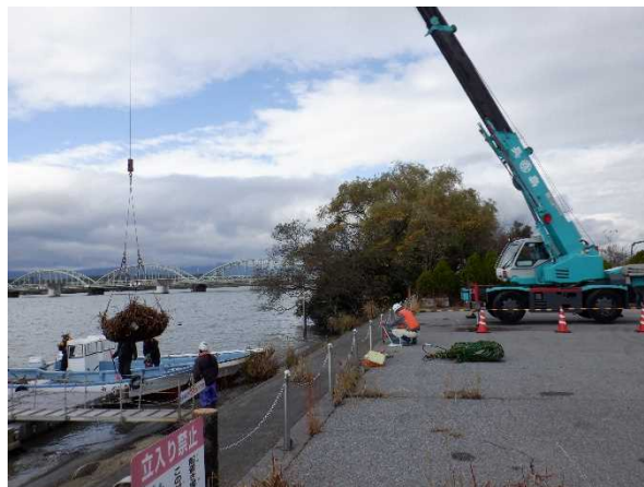
漂着物の陸揚げ作業 (令和4年12月)
