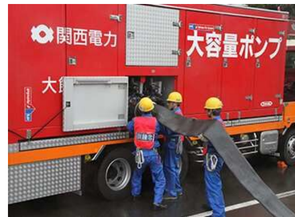
大容量ポンプ設置訓練
