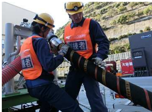
可搬式代替低圧注水ポンプ 設置訓練
