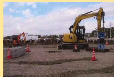
無線重機によるガレキ処理
