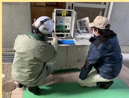
簡易電子式線量計の設置訓練 (2023年1月 静岡県吉田町)
