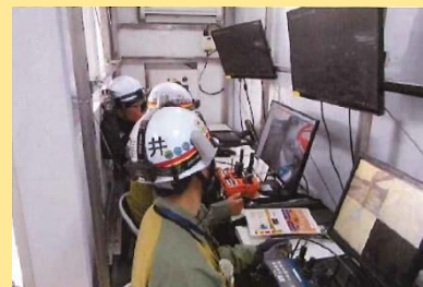
無線重機操作室
