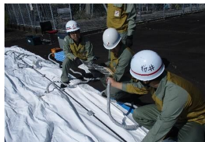
拠点の設営作業
