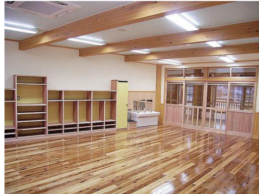
スギの圧縮材を利用した事例
