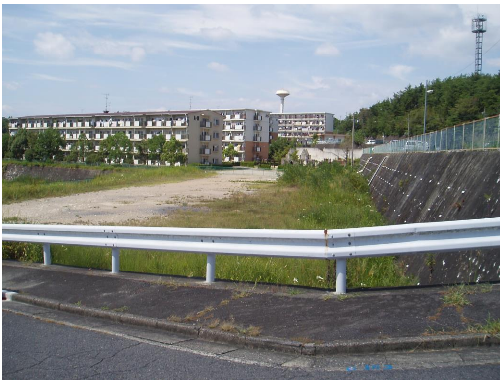
物件南方向から北方向を撮影（1番3の全景）
