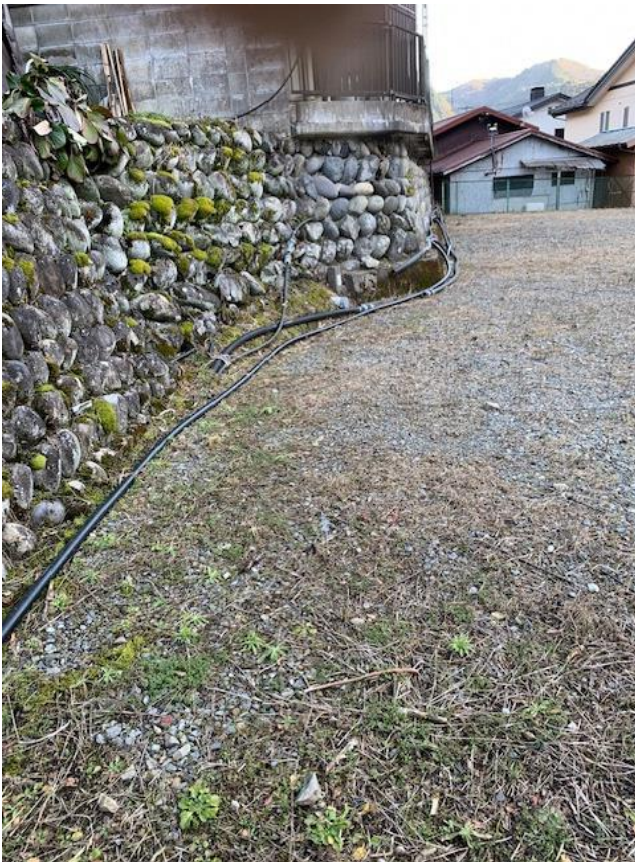
敷地内（北東境界付近）から南東方向を撮影
