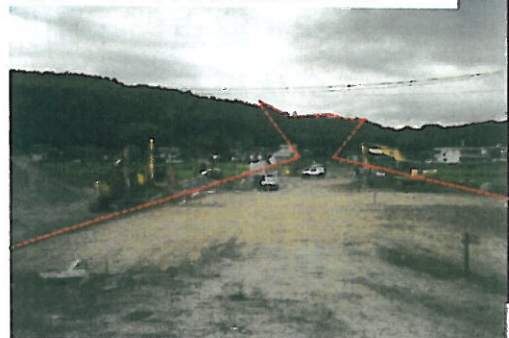
②施工中区間(関市方面を望む)
