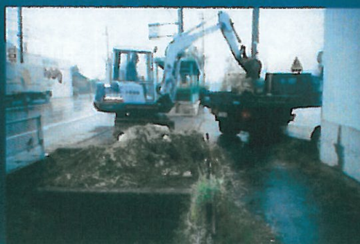
ゴミ除去の作業状況
