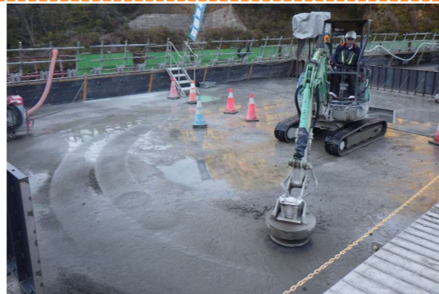
コンクリート打ち継ぎ目処理(グリーンカット)
