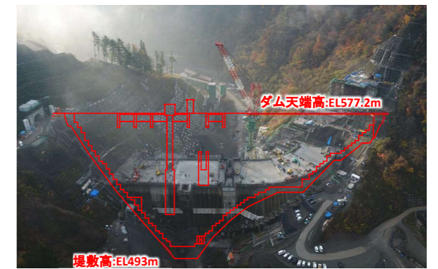
④ ダムサイト状況(上流上空より望む)
