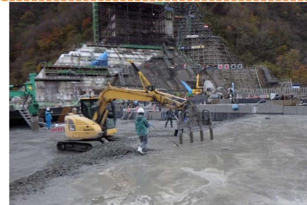
堤体コンクリート打設(締め)
