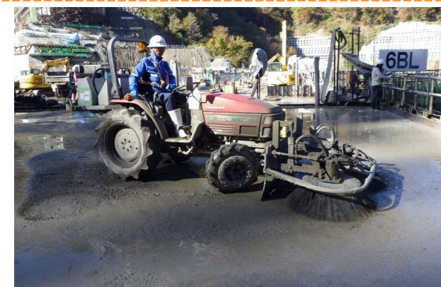
コンクリート打ち継ぎ目処理(グリーンカット)
