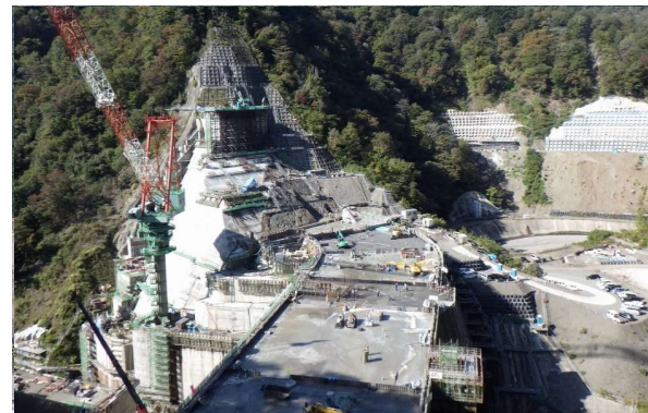
② ダムサイト右岸状況(左岸天端より望む)
