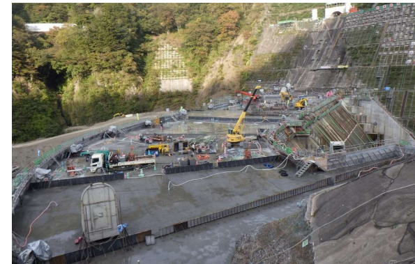
③ ダムサイト左岸状況(右岸天端より望む)
