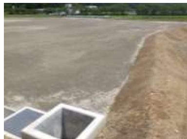
ガセインテック 駐車場 造成工事
