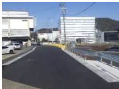
刃物ミュージアム 外構工事
