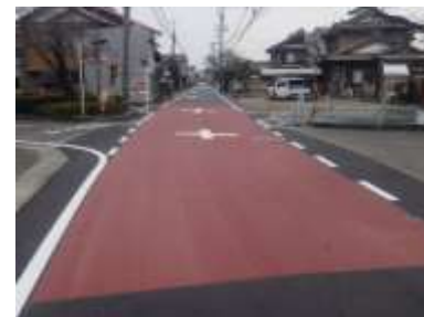
中福野町他 舗装補修工事
