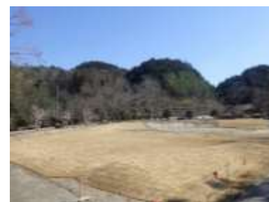
百年公園 公園施設再整備工事
