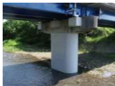
江底橋 耐震補強工事
