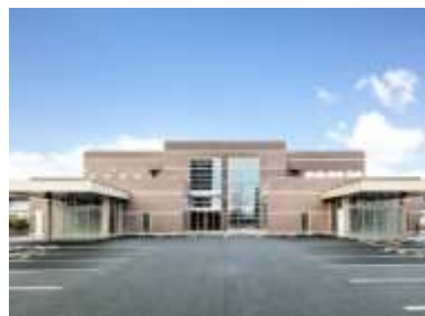
(株)岐装会 関ルネス 新築工事
