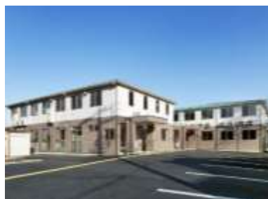
エンゼルランプ老人ホーム 新築工事
