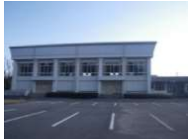
中池体育館 耐震補強等工事
