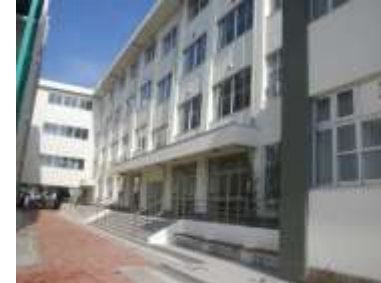
緑ヶ丘中学校北舎 改築（建築）工事
