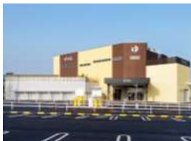
常滑温泉 マーゴの湯 新築工事
