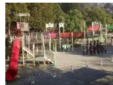
百年公園 都市公園整備工事
