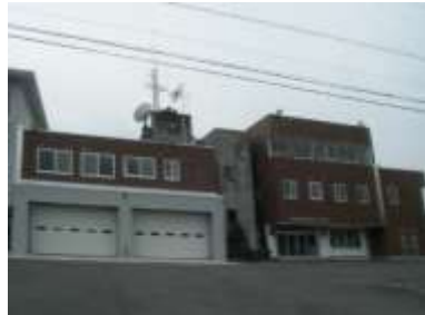
関消防署 増改築工事
