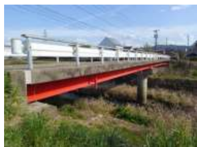
大保木橋他 橋梁補修工事
