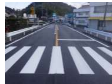
平和通 舗装補修工事
