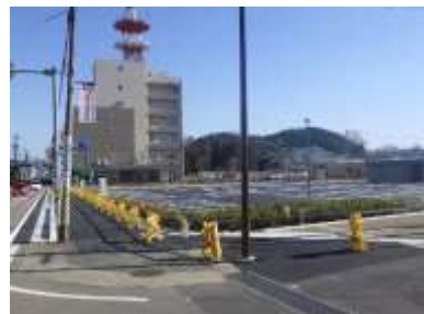
刃物ミュージアム 道路整備工事
