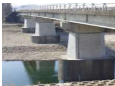
千足橋 耐震補強工事
