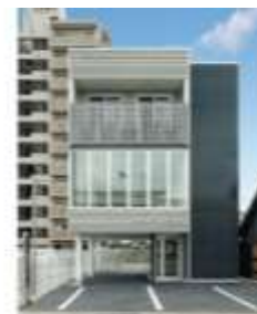
岐阜新聞社美濃加茂総局 新築工事
