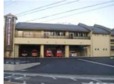
美濃消防署 建設に伴う主体工事
