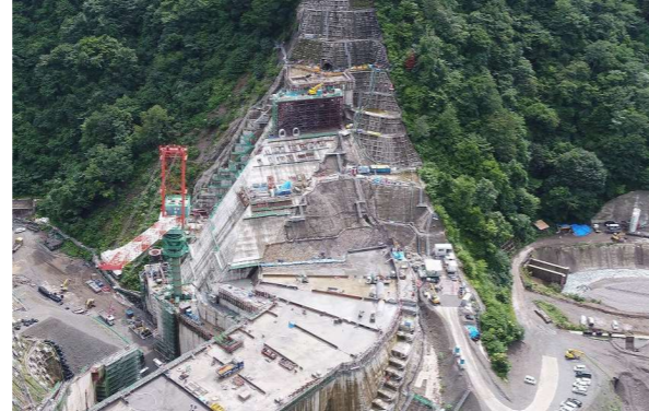
② ダムサイト右岸状況(左岸上空より望む)
