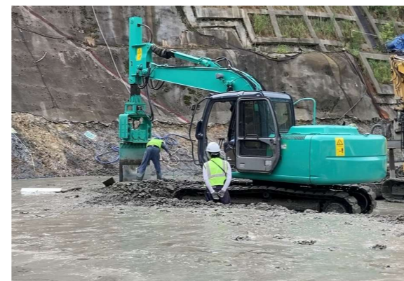
拡張レア工法 目地切り施工
