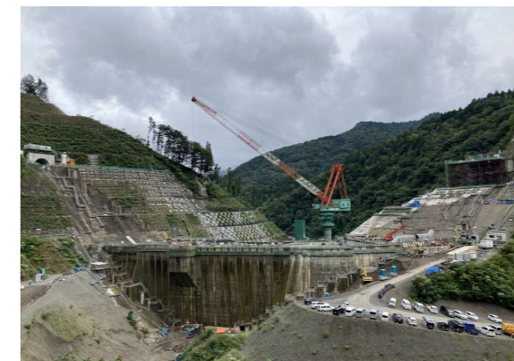
堤体上流側 EL535.25m
