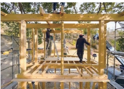
オール川辺町産材の木組が見えるシンボルデッキ
