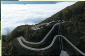
令和4年度完成展望台周辺設備
