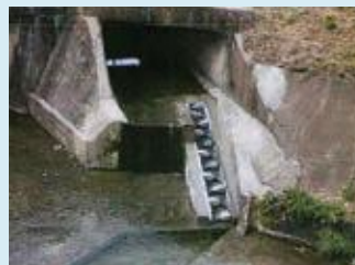
9-④ 用排水路・河川落差解消後
