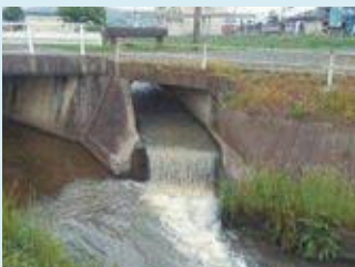
9-③ 用排水路・河川落差解消前
