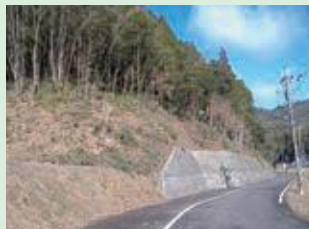
2-② バッファーズーン整備後
