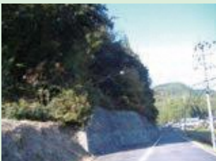
2-② バッファーズーン整備前
