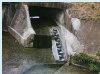
9-③ 用排水路・河川落差解消後
