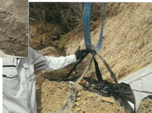
大型土のう吊り帯とスリングロープとの間に左手指を挟まれ被災した。
