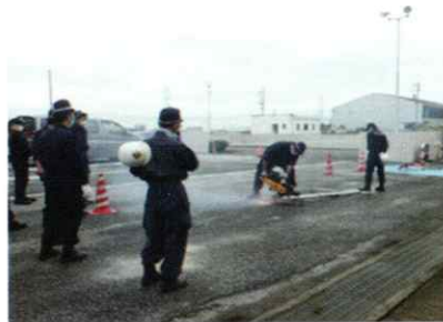
エンジンカッターによる金属切断
