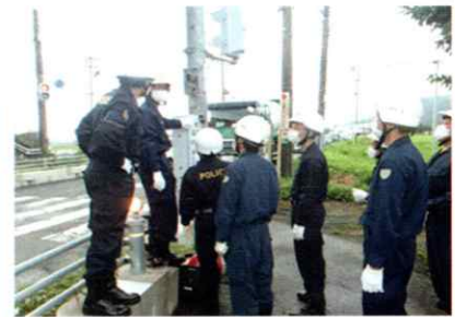
滅灯信号機の復旧
