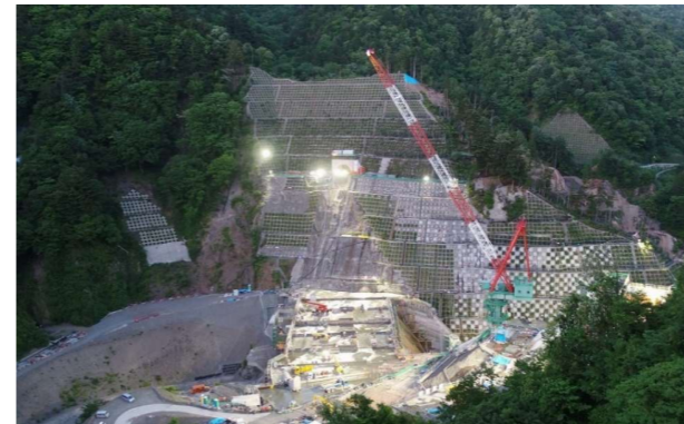
③ ダムサイト左岸状況(右岸上空より望む)
