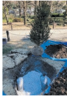
透水性・通気性確保のための土壌改良
