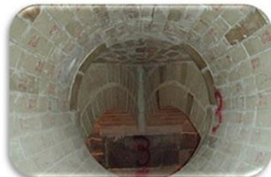
耐火物施工工事
