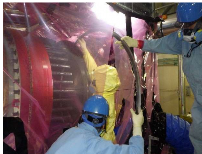
【再稼動前点検】 余熱除去クーラ開放点検 (水室側ガスケット取替作業)
